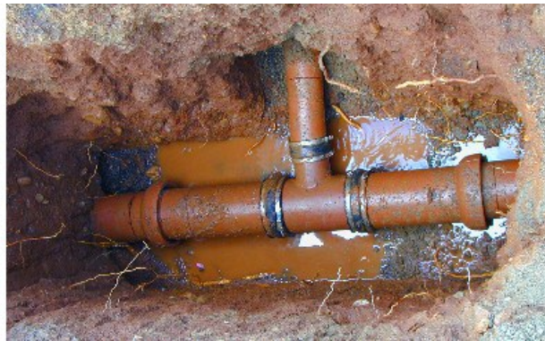
Figure 7. Spot Repair Deerfield Av 2
